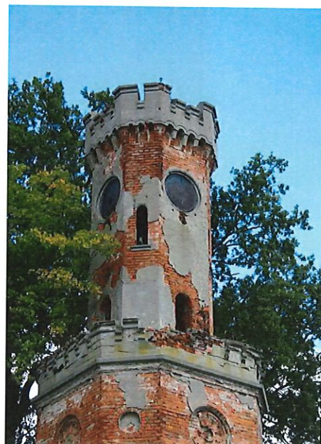
ruiny wieży widokowej w Warszynie
